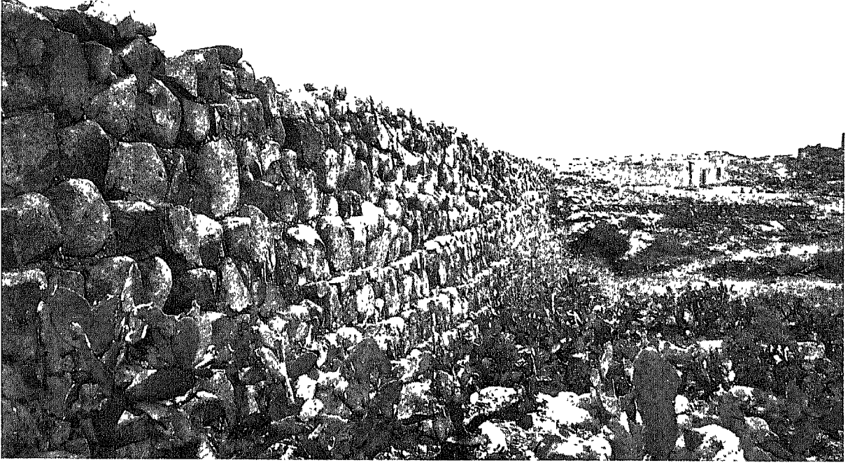
اللوحة ٢١ : الواجهة الشمالية لسد السملقي . وتظهر تفاصيل البناء من الحجارة التي وضعت على شكل مداмик مدرجة (تصوير المؤلف).
